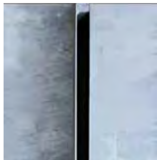
COPERTURA A FESSURA
